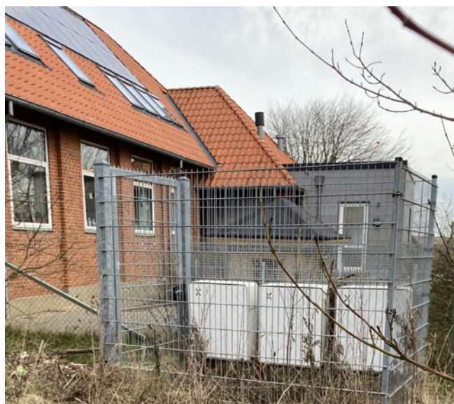
Solcelleanlæg og tilhørende batterier til oplagring af grøn strøm på Eltang Skole.
