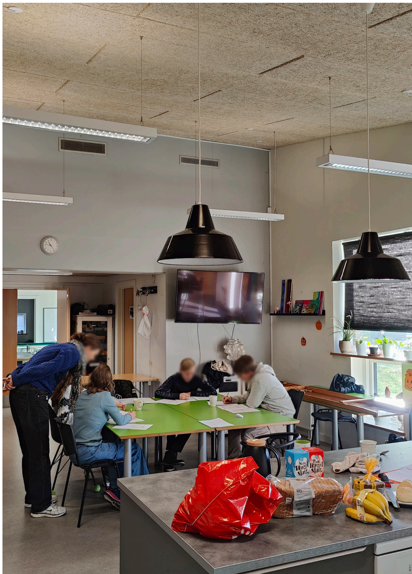
Ombygning af belysningsarmaturer, Munkevænget Skole.
